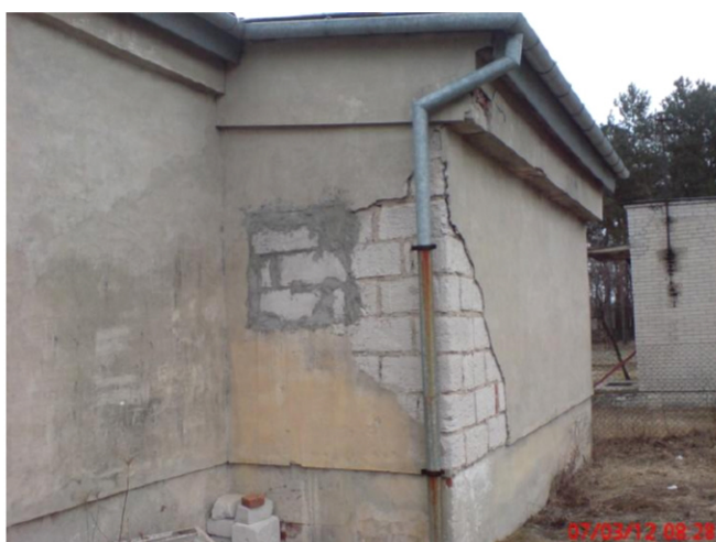
ŚCIANA Z USZKODZONYM TYNKIEM
